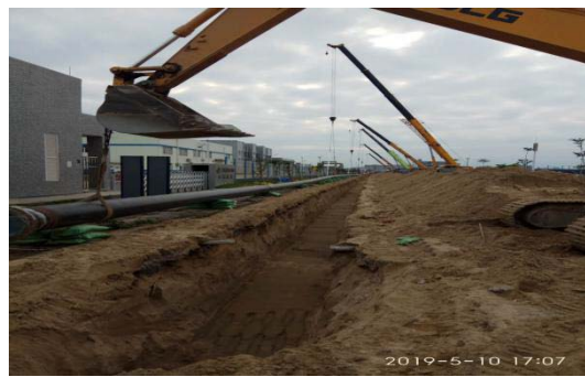
施工现场-管道敷设4
