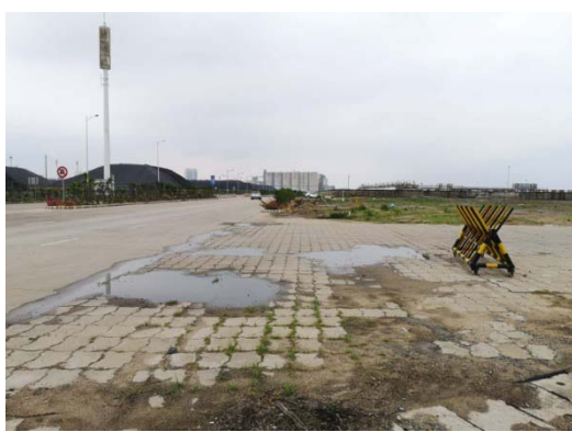
管道穿越道路2
