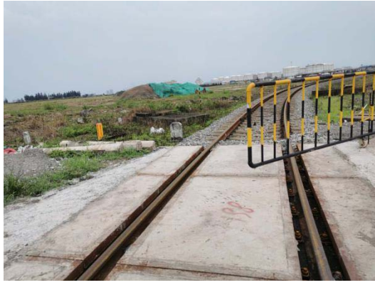
管道穿越铁路1
