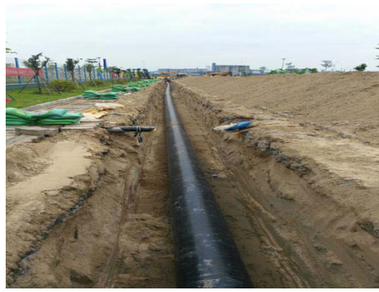
施工现场-管道敷设2
