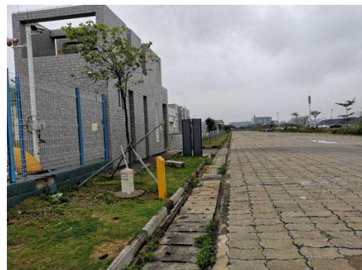
管道穿越道路2
