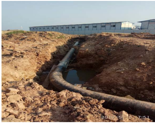
施工现场-管道敷设1
