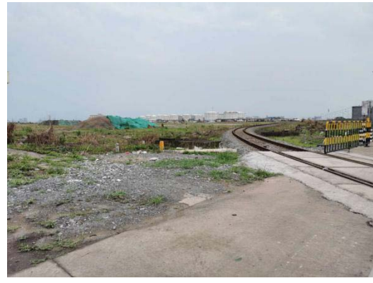
管道穿越铁路1
