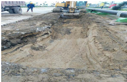
施工现场-管道敷设3
