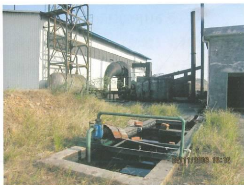
锅炉废气处理系统
