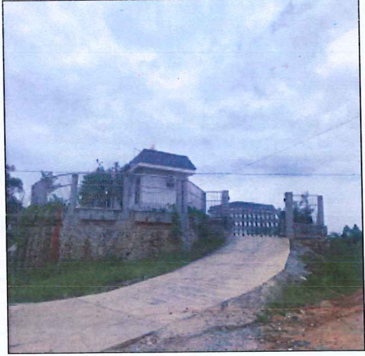
在妙镇污水处理厂大门（厂界西面）
