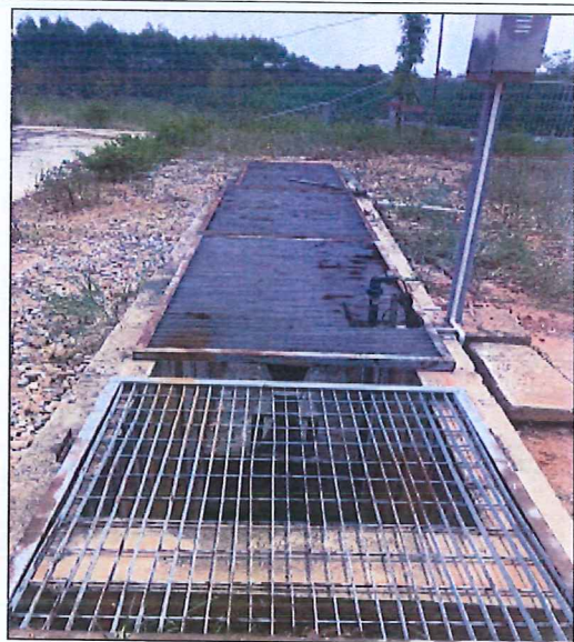
(11) 废水总排口处
