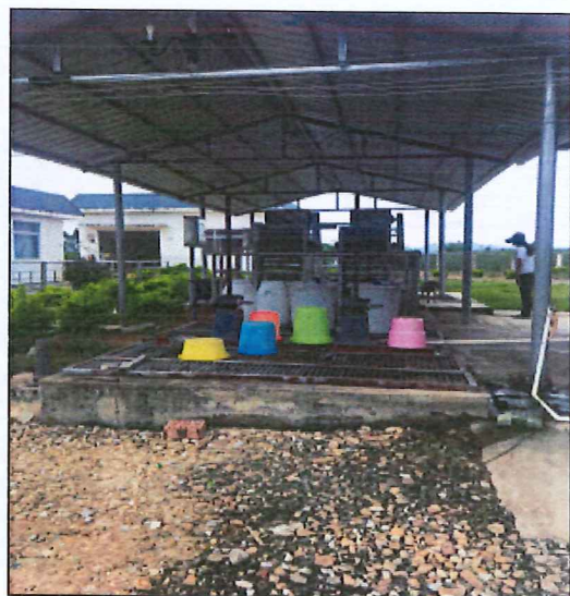
(1) 污水管网入口处
